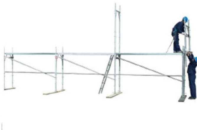
28 • montagem do quadro no primeiro nível
