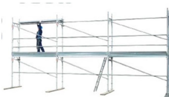
43 • montagem da plataforma metálica do segundo nível
