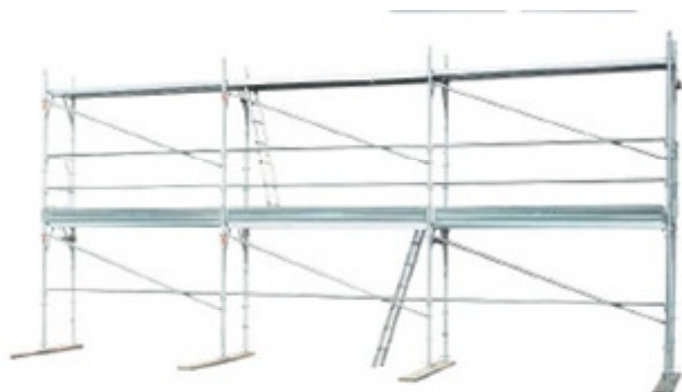
46 • montagem das plataformas metálicas em todo o segundo nível
