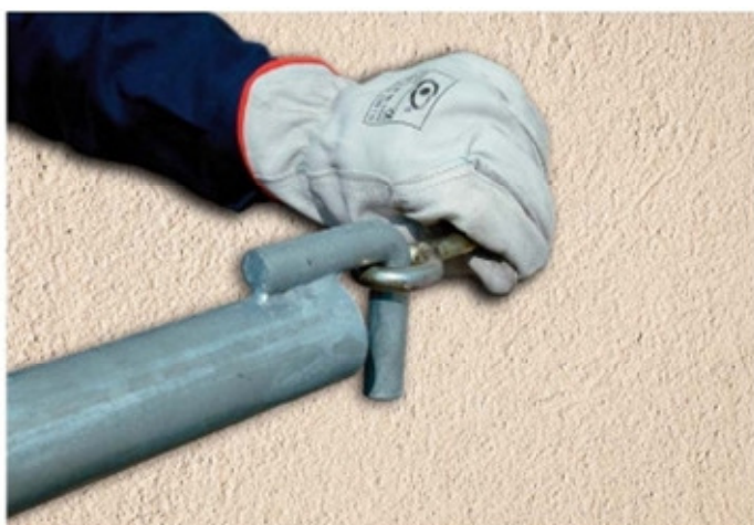
15 • colocação da ancoragem
