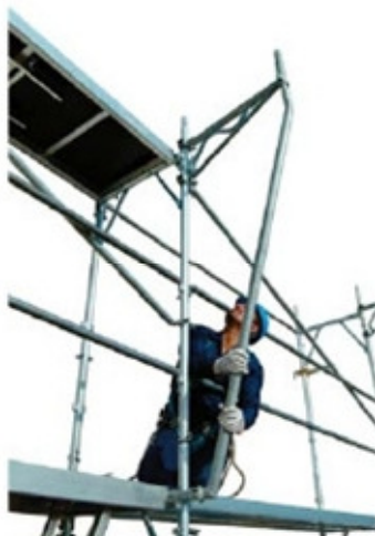
59 • montagem do tubo de apoio da mão francesa
