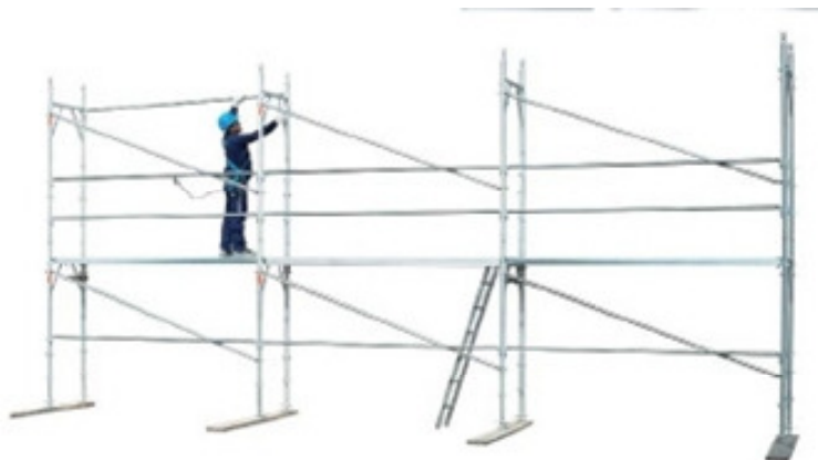
33 • montagem do módulo sucessível do primeiro nível
