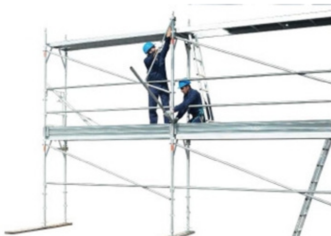
52 • montagem do aparalixo
