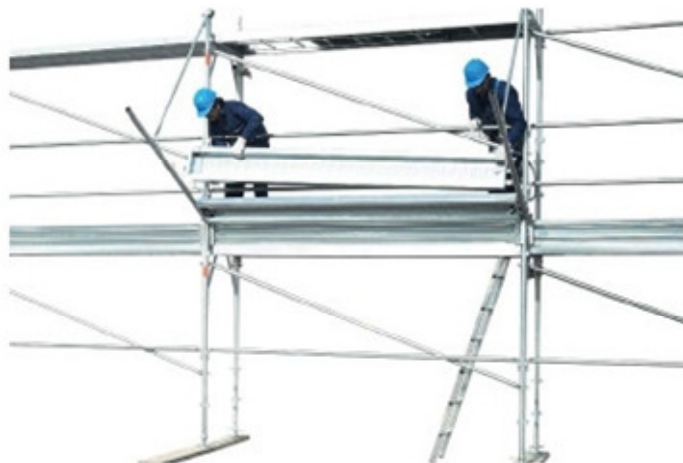
56 • colocação da plataforma do aparalixo
