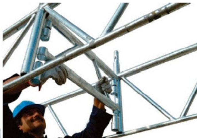
66 • colocação da viga de ligação
