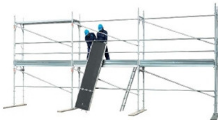
44 • montagem da plataforma com alçapão do segundo nível
