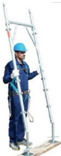
2 • posicionamento do quadro
