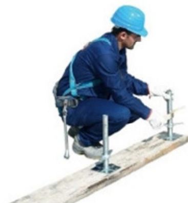
1 • posicionamento da sapata
