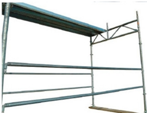
64 • colocação da plataforma metálica sobre o quadro pendonale
