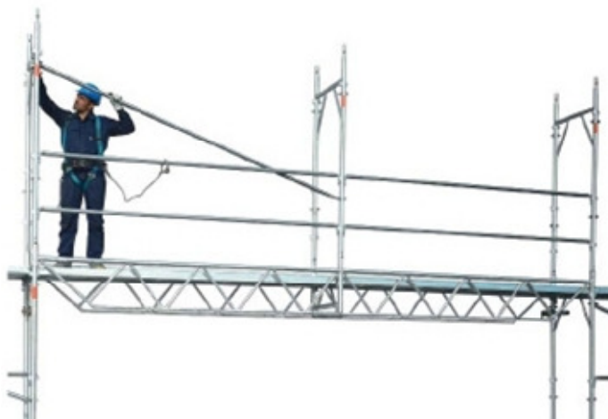
69 • colocação de diagonal sobre a viga treliçada
