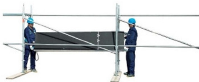
18 • montagem da plataforma com alçapão
