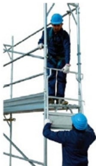
39 • colocação da cancela de topo do primeiro nível
