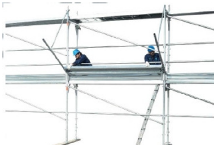
55 • colocação da plataforma do aparalixo
