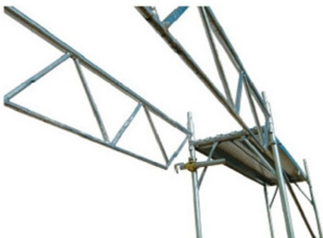
65 • montagem da viga treliçada
