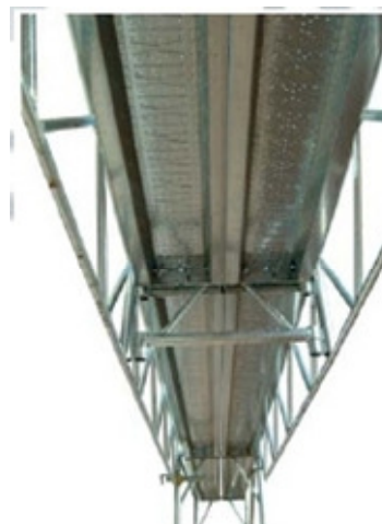
67 • montagem do convês sobre a viga treliçada
