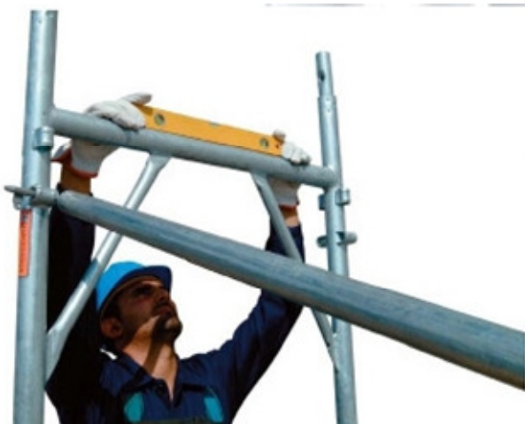
8 • verificação de nível
