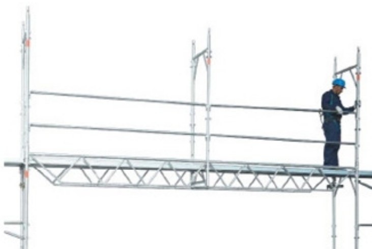
68 • montagem de quadros e guarda corpos sobre a viga treliçada
