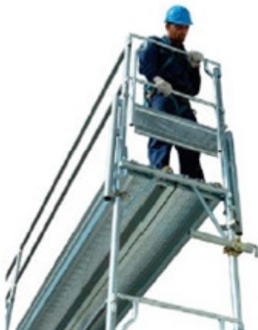
51 • montagem da cancela de topo do segundo nível
