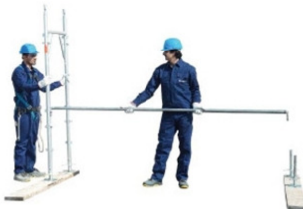
4 • colocação do guarda corpo
