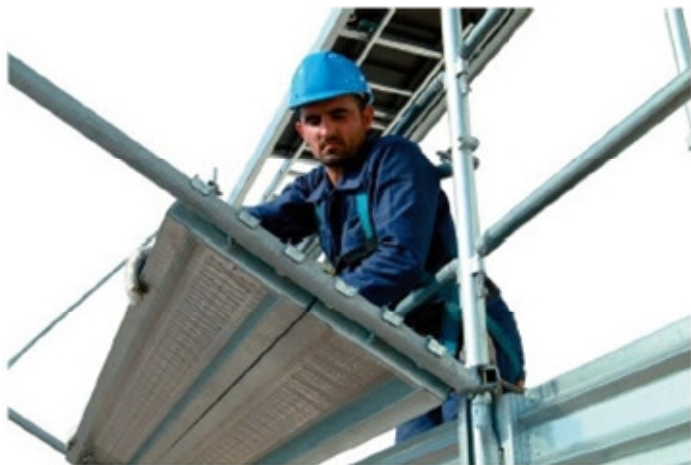
57 • detalhe da montagem da plataforma do aparalixo
