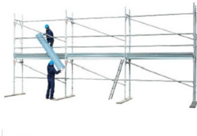
42 • montagem da plataforma metálica do segundo nível
