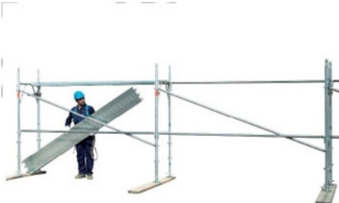
17 • montagem da plataforma metálica
