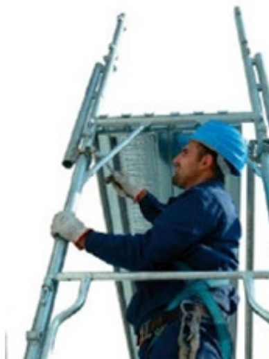
48 encaixar a abraçadeira do montante no quadro
