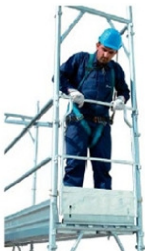
40 • colocação da cancela de topo do primeiro nível
