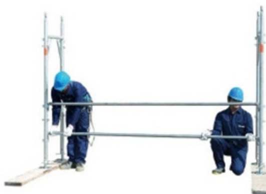
6 • montagem com guarda corpo
