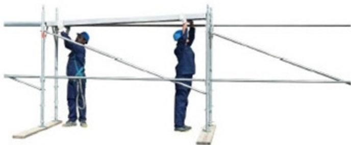
19 • montagem da plataforma com alçapão
