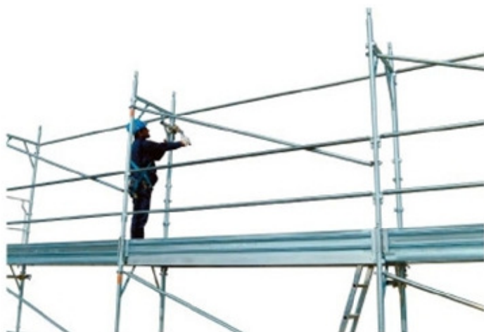
41 • colocação do tubo de ancoragem se necessário
