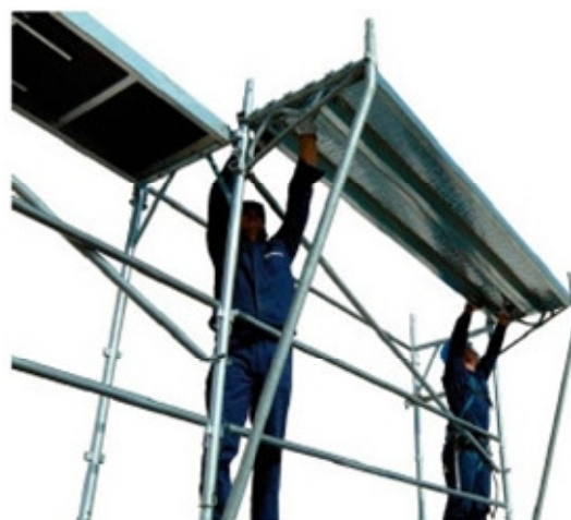
62 • colocação da plataforma metálica sobre a mão francesa
