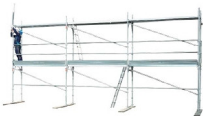
47 • colocação do montante de segurança no segundo nível
