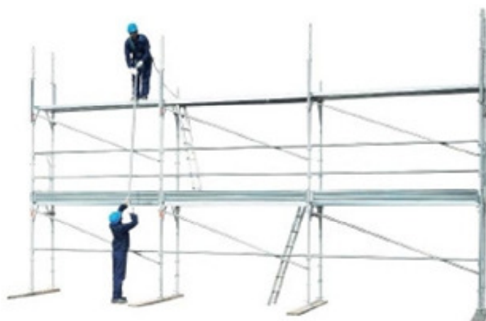
50 • colocação de guarda corpo do segundo nível
