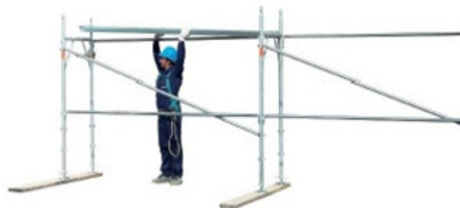
16 • montagem da plataforma metálica
