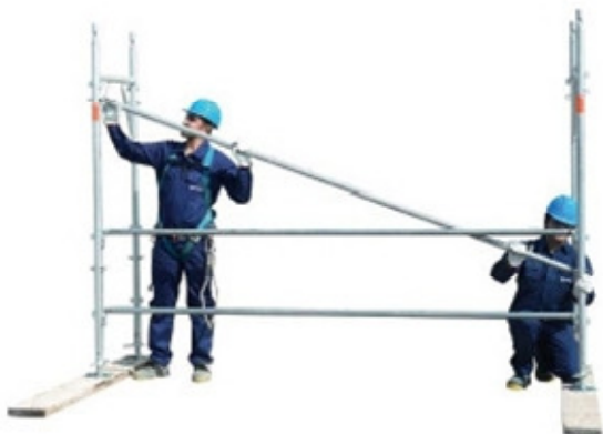
7 • colocação de diagonal
