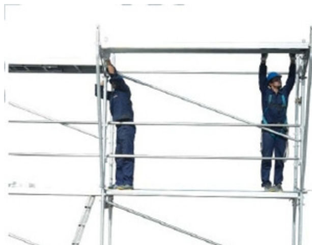
61 • colocação da plataforma metálica sobre a mão francesa
