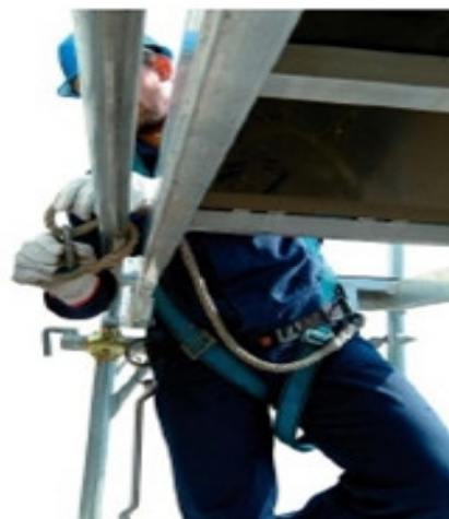
24 • atrelamento do cinto de segurança antes de sair ao nível superior
