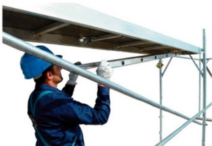
21 • colocação da escada na plataforma
