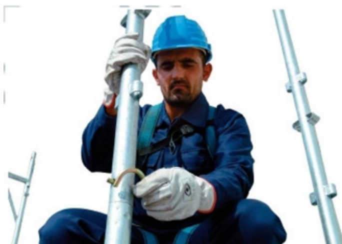
29 • colocação do gancho de segurança
