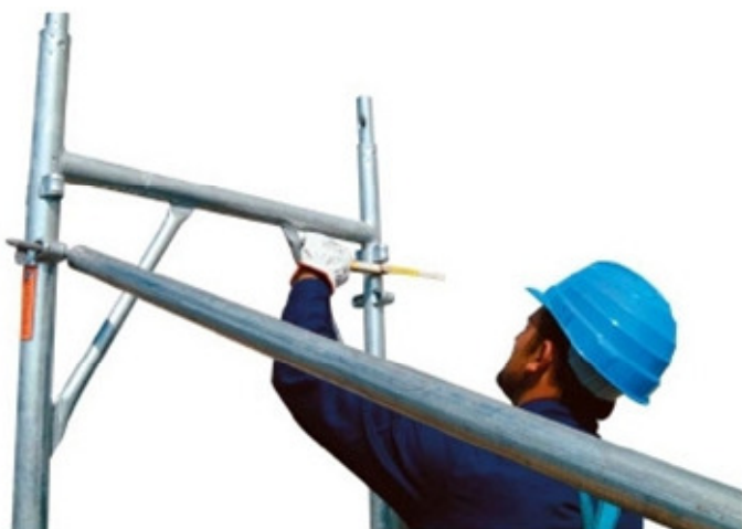
10 • verificação de distância da fachada
