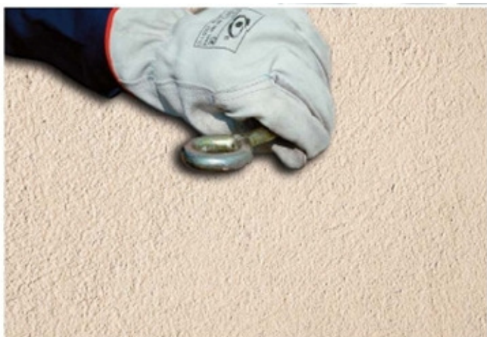
14 • colocação da ancoragem
