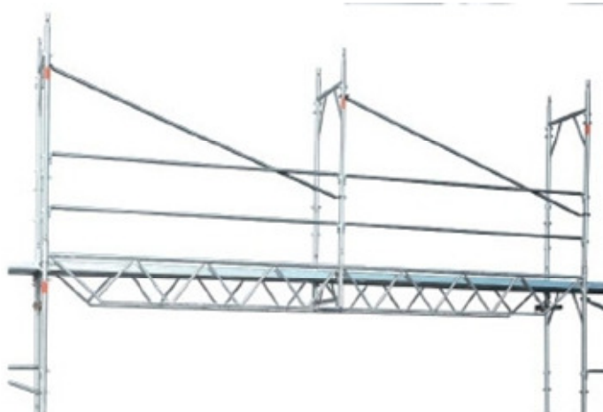
70 • término da montagem sobre a viga treliçada
